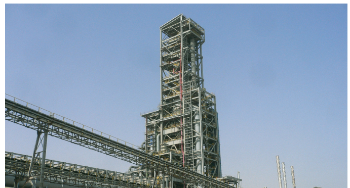
Qatar Steel Module 2
