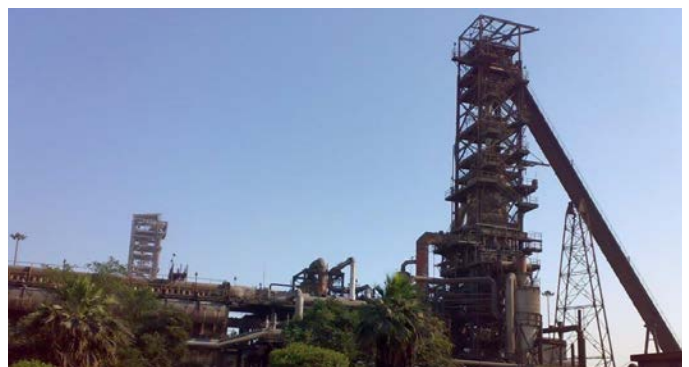
Qatar Steel Module 1
