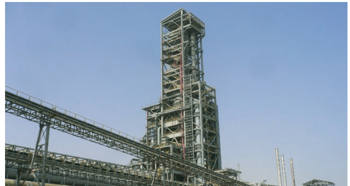
Qatar Steel Module 2
