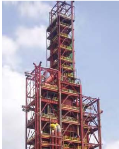
Essar Steel Module V
